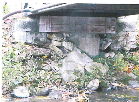
Pravobřežní opěra s patrným podemletím
